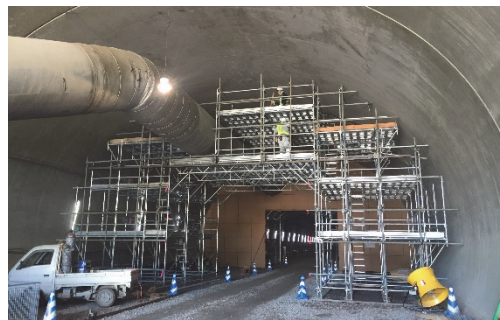
写真 6 特殊風門用の支保工設置状況
