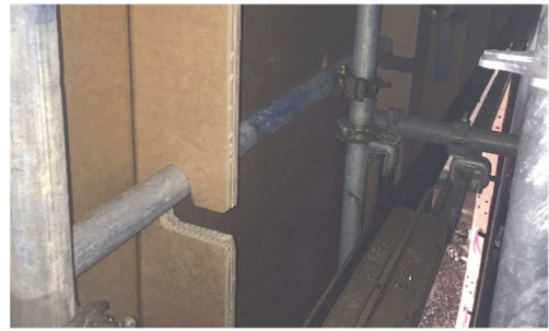
写真 9 切り欠きによる支保工への固定状況
