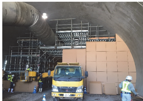
写真 8 特殊風門の組立状況
