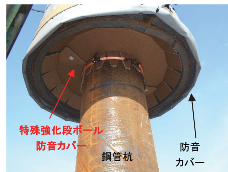
写真 5 特殊強化段ボール防音カバー
