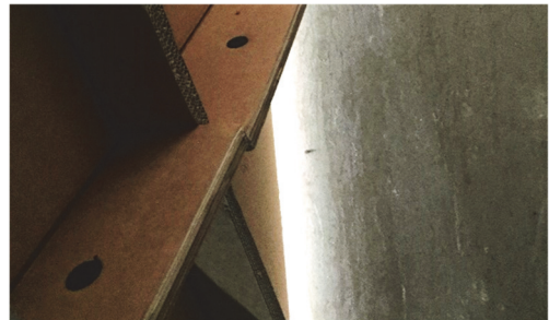
写真 10 特殊ネジによる隣接部材の接合
