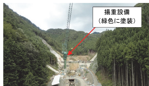
写真 12 アースカラーの揚重設備
