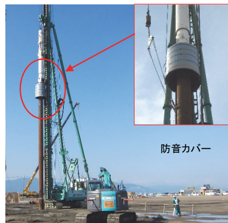
写真 4 杭打機および防音カバー
