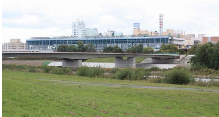
写真4 完成間近な駅舎と開通した氷点橋
