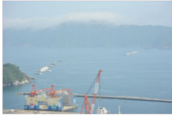
図3 釜石市の湾口防波堤 .
