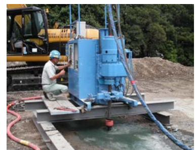
写真-3 切削試験状況
