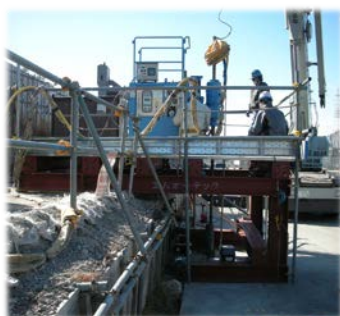
写真-7 施工確認試験状況
