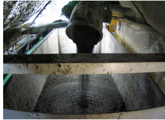
写真-8 排土状況
