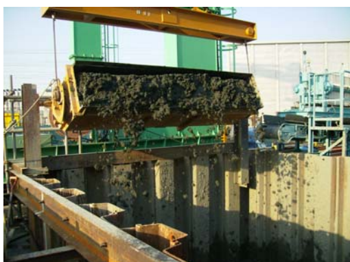
写真-5 排土状況(土砂ピット)
