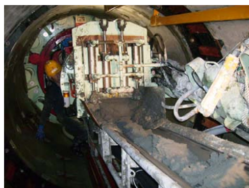
写真-4 排土状況(切羽)
