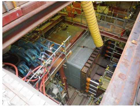
図 2.5.2 発進立坑内設備配置状況
