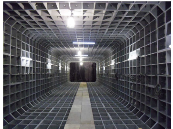
図 3.1.1 トンネル内一次覆工完了状況
