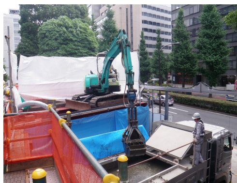
図 2.5.1 発進立坑汚泥搬出状況
