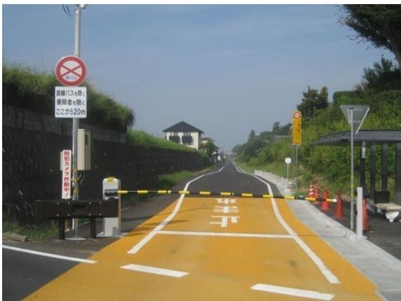
【写真1】 交差点部の着色舗装と片側遮断機
