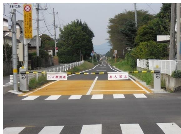
【写真2】 交差点部の着色舗装と両側遮断機
