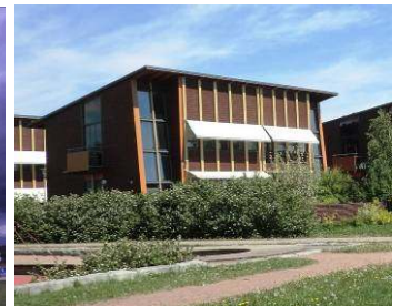
写真4 パッシブ住宅
