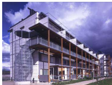
写真3 木造バルコニーの中層住宅
