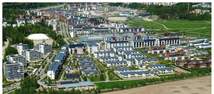
写真1 南西からの全景写真
