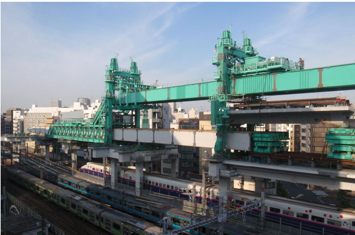
写真-1 東北新幹線直上の桁架設機と搭載直前の PC 桁
