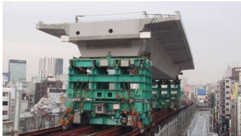
写真-4 昼間待機中・自走台車上の PC 桁
