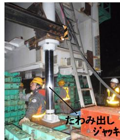
写真-9 走行ガード後端のたわみ出し
