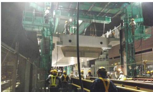
写真-6 PC 桁の降下・架設
