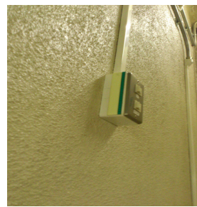
写真5 非常電源も消失した場合に備えて、電源スイッチにも蓄光+反射テープを設置したことで暗い室内でも認識ができる。
