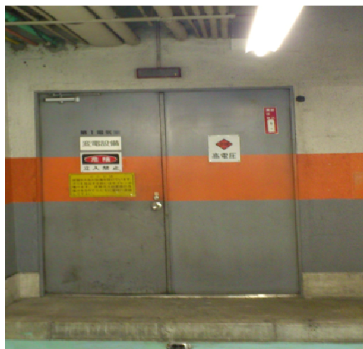
写真1 ドア壁面に設置されていたボードを蓄光シートで作成。ドア枠には蓄光テープ+反射テープを使用。 (表1 No.①、No.②)
