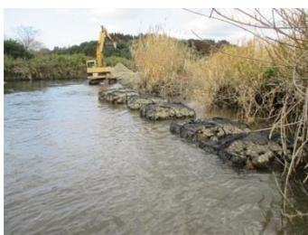
写真-4 重機による設置状況
