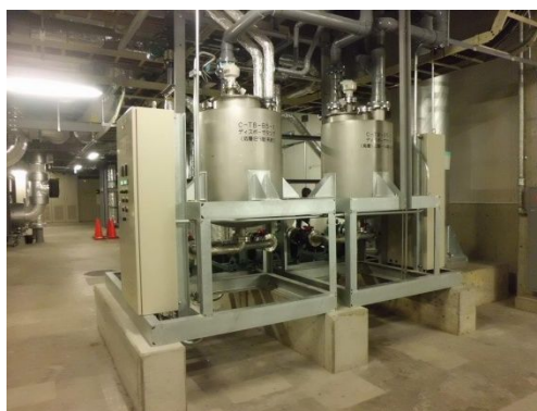
図3 ディスポーザ中継システム
