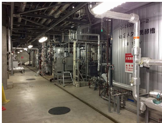
図5 メタン発酵システム
