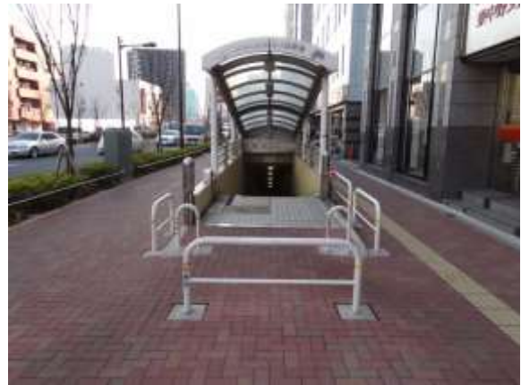
図-5 環6（山手通り）地下駐輪施設 ※写真は中野坂上駅（大江戸線）
