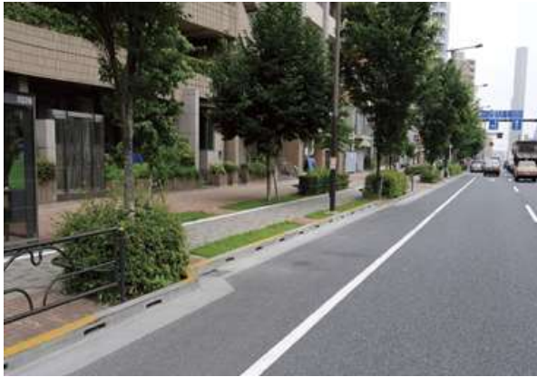
図-4 環6（山手通り）停車スペース
