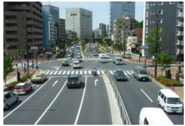
図-5 環6（山手通り）右折レーン設置
