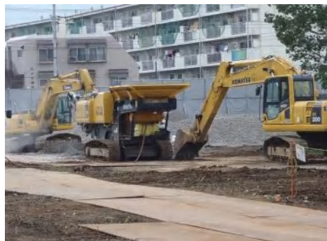
写真4 ガラ破砕状況
