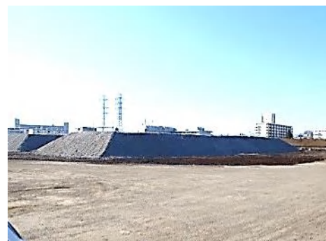
写真5 再生砕石集積状況
