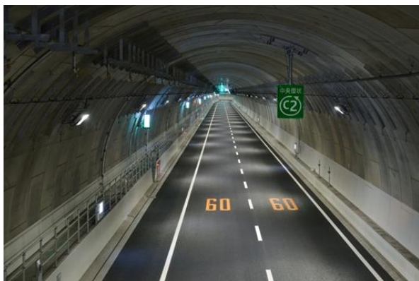
写真-4 完成後シールドトンネル(南行)
