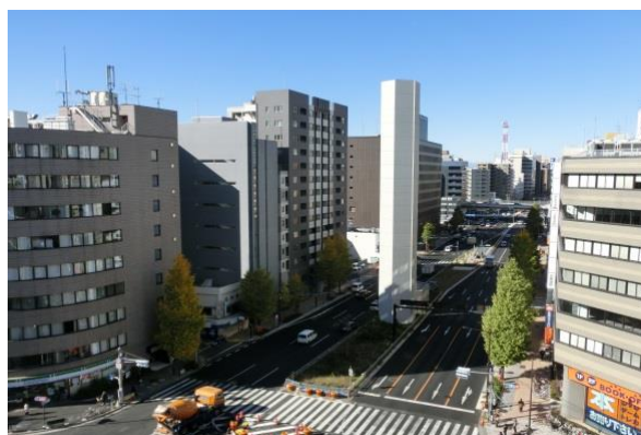
写真-5 換気所地表部(五反田換気所)
