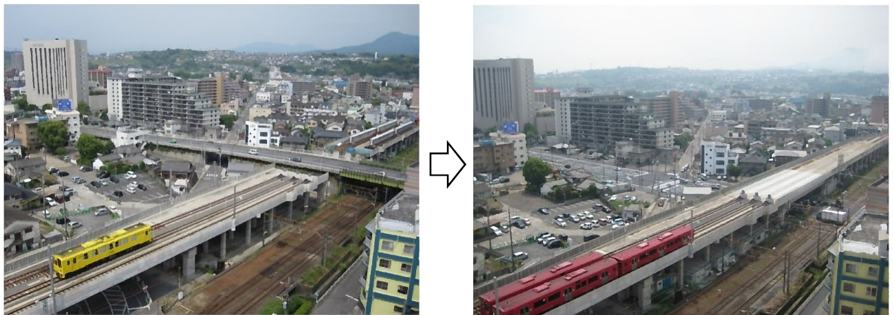
写真4 大道陸橋撤去前後の状況
