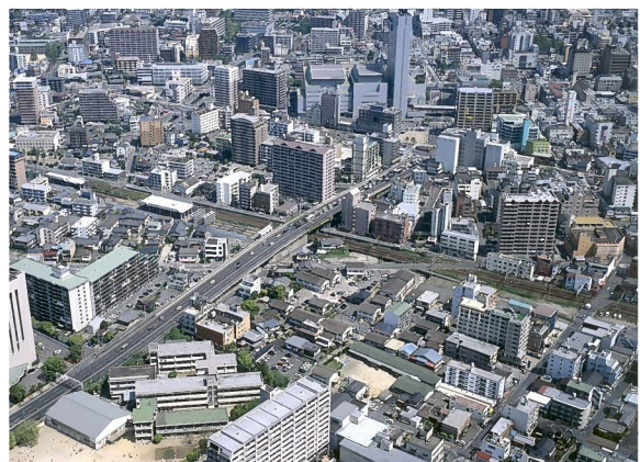
写真3 国道210号 大道陸橋周辺の状況
