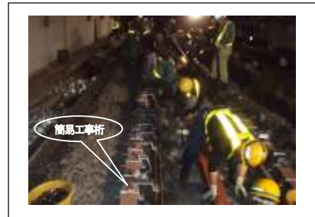
写真-2 簡易工事桁設置状況
