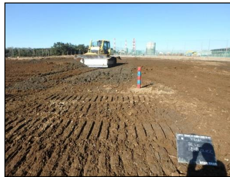
写真4 中央標尺による出来形管理
