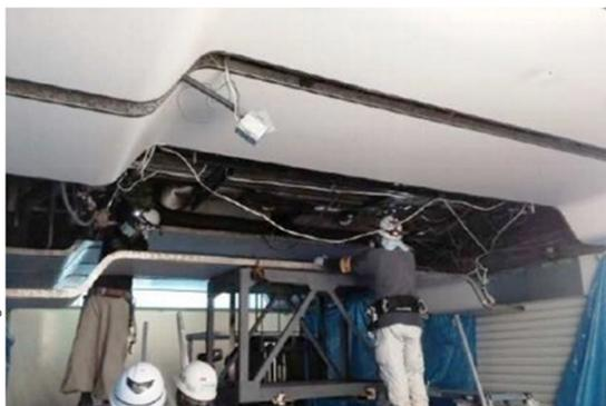
写真 3 既存天井板の撤去状況
