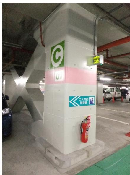
写真 3 地下駐車場の柱補強(鋼板巻き)
