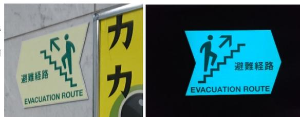
写真 1 (上)蓄光材が塗装された階段 左:通常時、右:発光時 (下)避難経路を示す壁面ピクト 左:通常時、右:発光時
