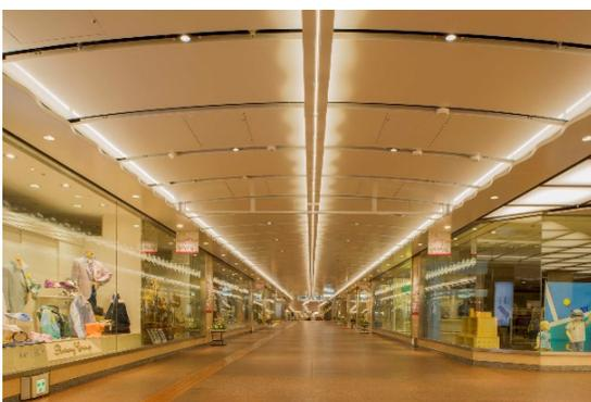
写真 4 軽量天井板を採用した通路部の天井
