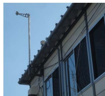
写真 5 基準局の設置例
