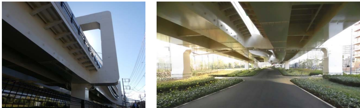
写真5 整備後の写真(左:橋脚の面取り、右:剛構造)
