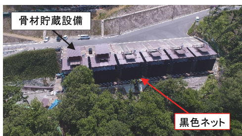
写真 13 黒色ネットによる骨材温度上昇防止
