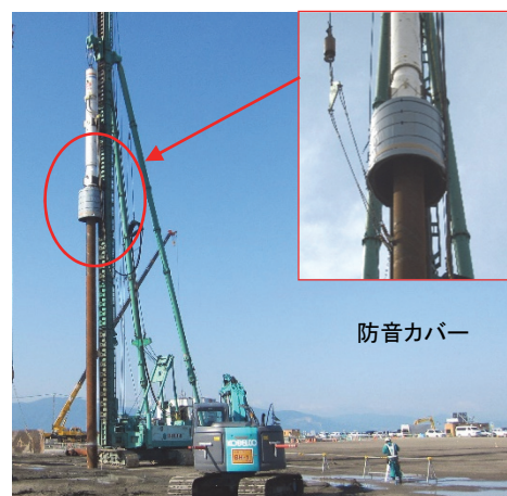
写真 4 杭打機および防音カバー
