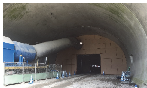
写真 11 特殊風門の設置完了状況
