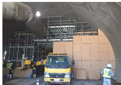
写真 8 特殊風門の組立状況
