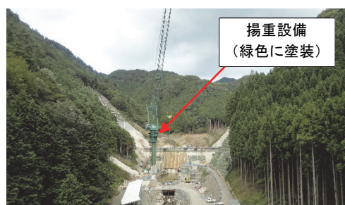
写真 12 アースカラーの揚重設備
