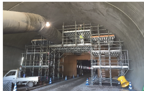
写真 6 特殊風門用の支保工設置状況
