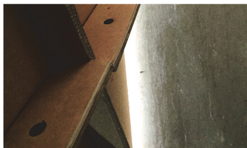
写真 10 特殊ネジによる隣接部材の接合
