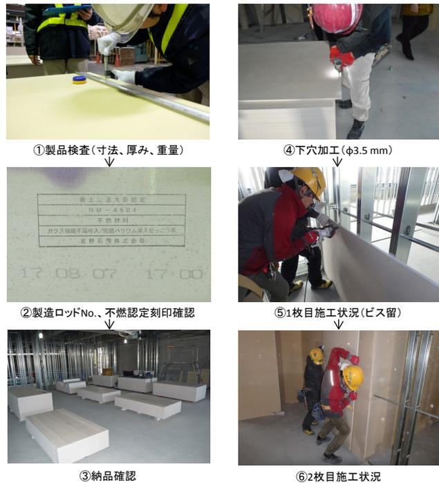
図 13. 製造から施工までの品質管理
