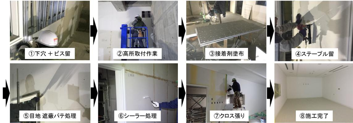
図 12. 放射線遮蔽せっこうボードの施工事例（クロス張り仕上げ）
