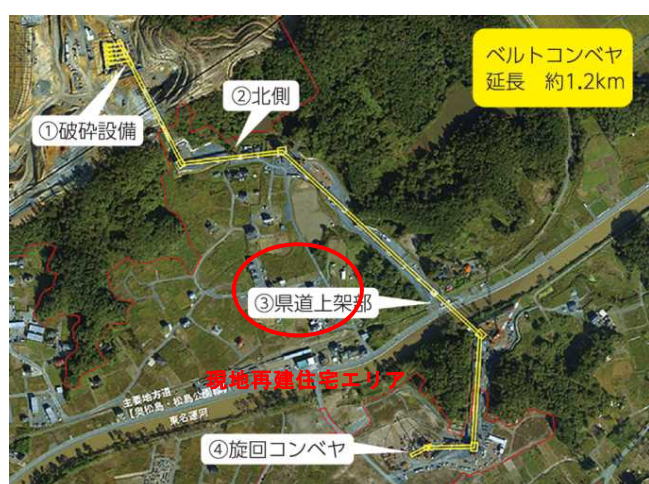
写真-1 ベルトコンベヤルート概要
