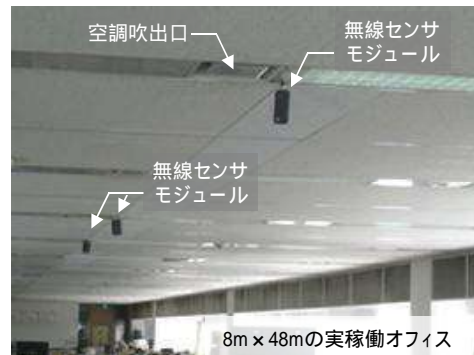
写真3 実稼働オフィスの実証試験
