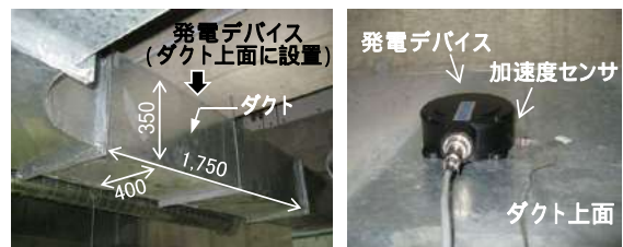
写真2 検証試験の実施状況
