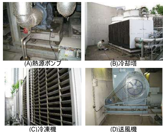
写真5 設備機器の振動測定状況
