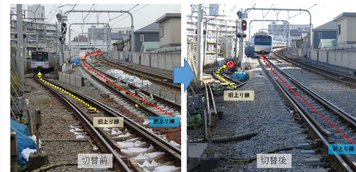
星川6号踏切付近の切替状況
