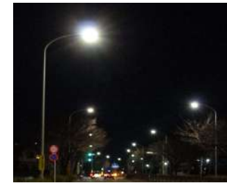
車道照明は、路線に応じ、平均路面輝度0.5～1.0cd/m 2 を確保しています。
