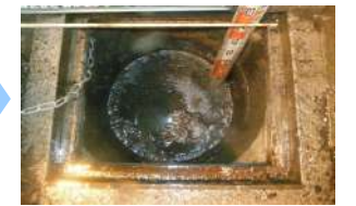
しゅんせつ実施後
