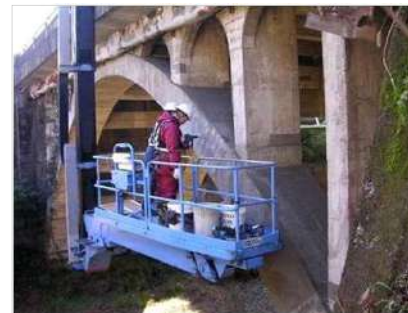
定期点検(5年に1度) 近接目視により、腐食、ひび割れなどを確認
