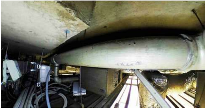
写真1 天井内の撮影状況
