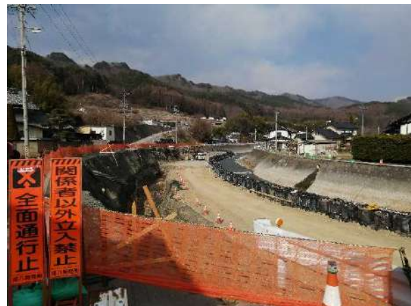
写真-4 工事の実施状況
