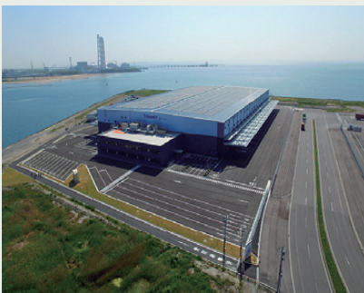
霞北埠頭流通センター 【三重県四日市市】(平成29年5月竣工) 物流機能の高度化及び防災機能の向上に貢献
