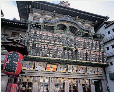
京都四條南座耐震改修計画 【京都市】(平成30年9月竣工) 耐震改修工事により、伝統を受け継ぐ劇場を維持保存
