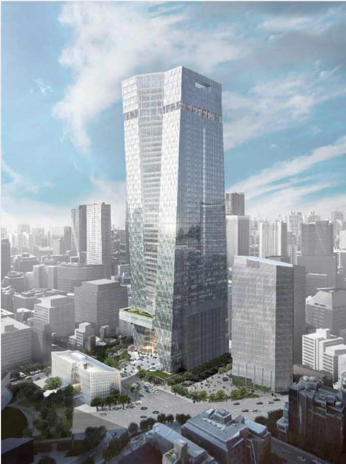
建物全体外観イメージ
