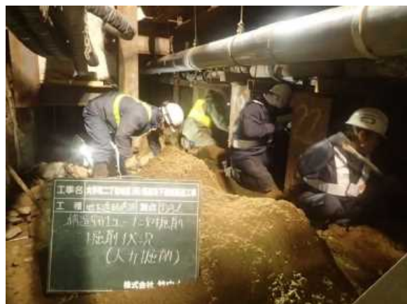
写真1 埋設管周囲の人力掘削状況
