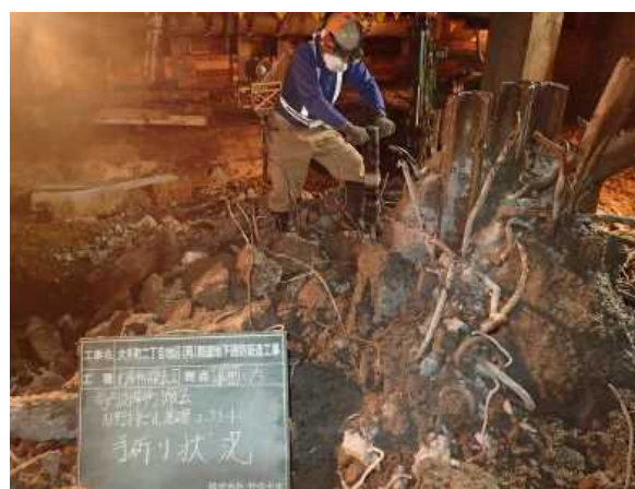
写真2 地下残置物の撤去状況
