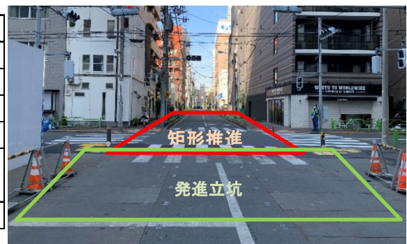
図2 路下発進立坑
