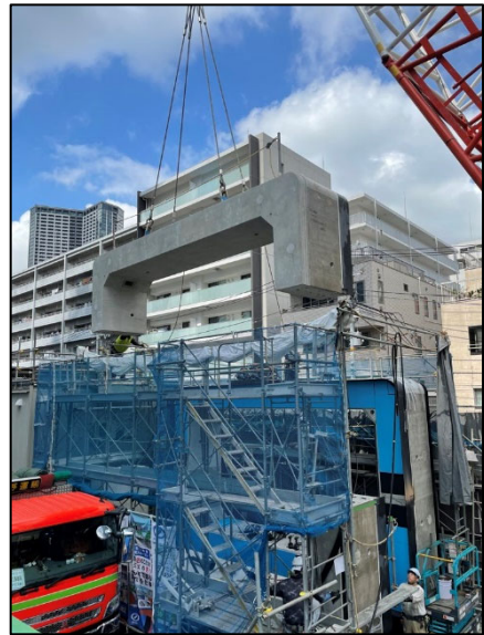
写真-3 推進管組立
