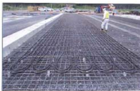
写真-15 乾燥テント床下状況
