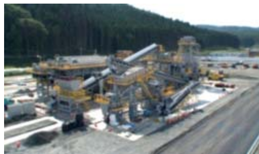
写真-9 土壌洗浄施設全景
