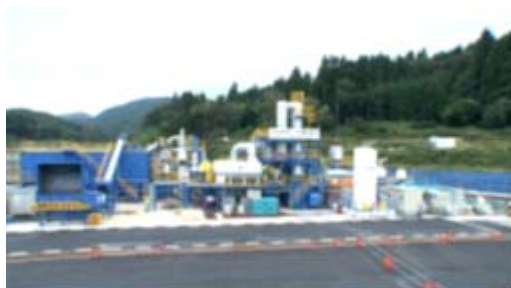
写真-12 木質バイオマス発電設備
