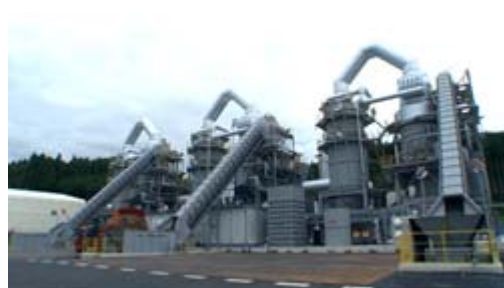
写真-13 焼却設備
