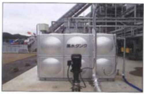
写真-14 焼却炉温水タンク
