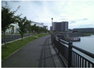
写真4 調節池敷地境界(園路左端部)に境界柵はない
