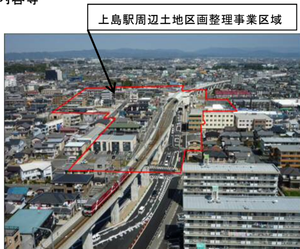
写真4 上島駅付近の現況(都)有玉南中田島線(一部供用)
