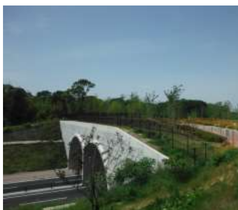
写真－4 施工状況
