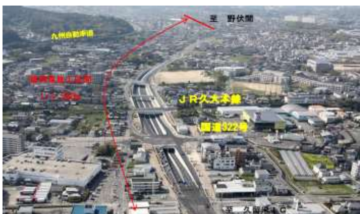
写真－2 立体交差部
