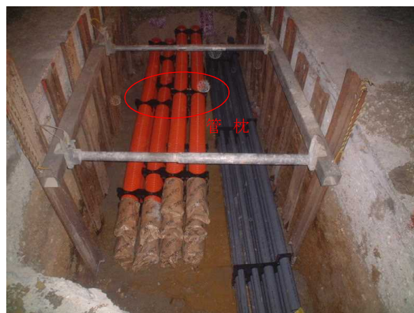
写真8 C・C・BOXの施工状況
