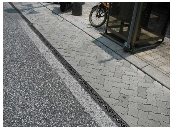
写真3 路肩のインターロッキングブロック
