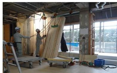
図 4 CLT 耐震壁の設置施工状況
