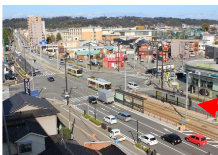
写真-5 複線化区間の状況
