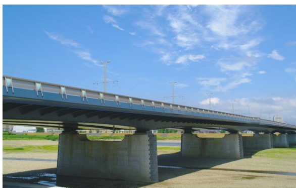
写真-2 新富山大橋全景
