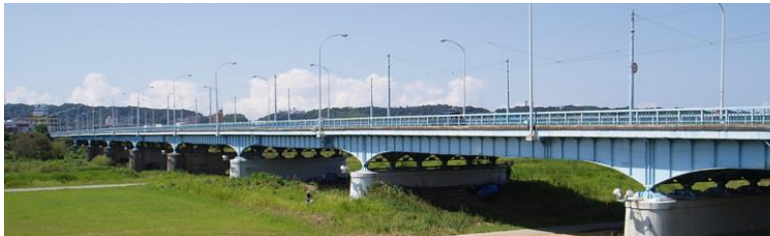
写真-1 旧富山大橋全景
