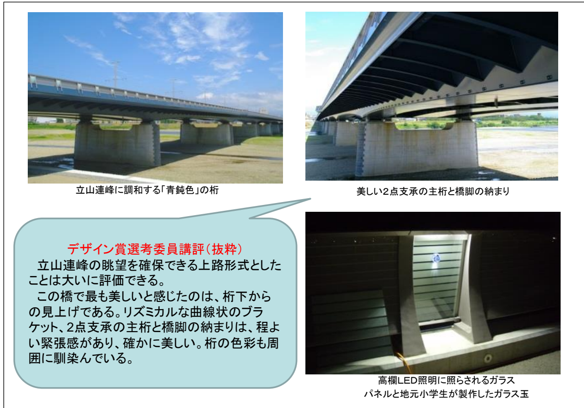
図-4 桁色、2 支承 3 主桁の採用、ガラス玉の設置
