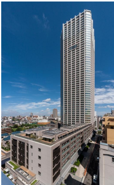
写真-2 南西側より全景(手前が中層棟)
