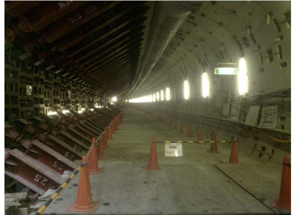
写真2 上野地下歩道者専用道 施工時坑内状況
