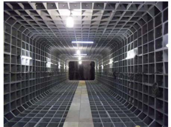
写真4 新御茶ノ水駅連絡出入口 貫通後坑内状況
