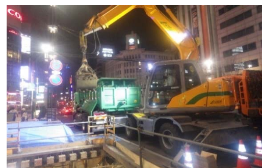
写真10 汚泥搬出状況
