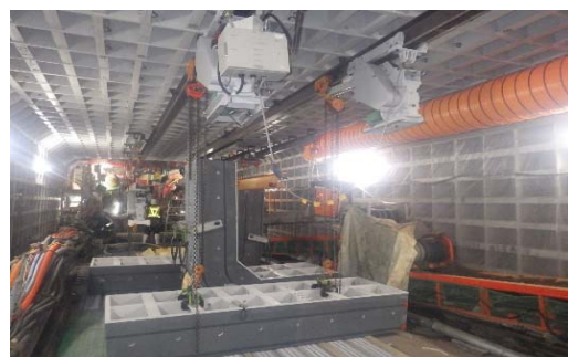
写真9 セグメント搬送状況
