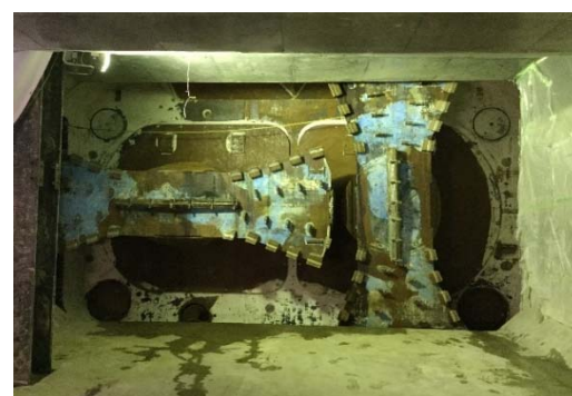
写真11 シールド機到達状況
