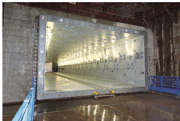
写真6 新日比谷通路新設 貫通後坑内状況
