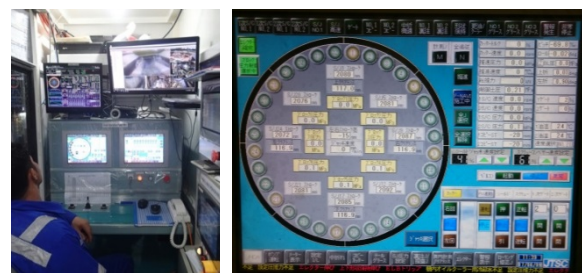
図-2 シールドマシンの操作状況(左)と操作盤(右)の例
