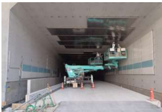
写真 4 トンネル内耐火板設置の様子
