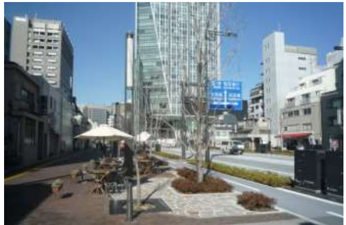
写真7 遮熱性舗装と自然石を用いた歩道舗装
