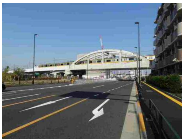
写真-5 PCランガー橋の景観(多摩3・3・7号線)
