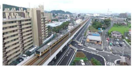
写真-1 完了状況(稲城長沼駅～南多摩駅間)
