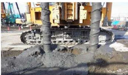
写真 5: 地盤改良工事途中の状況
