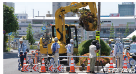
<着工(東大通り)>
