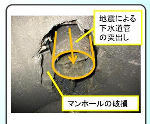
下水道管とマンホールの接続部の損傷
