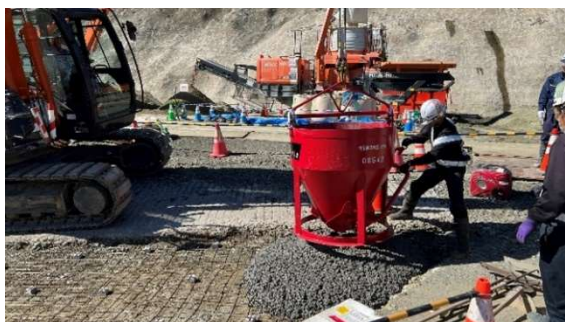
写真2 コンクリート打込み状況
