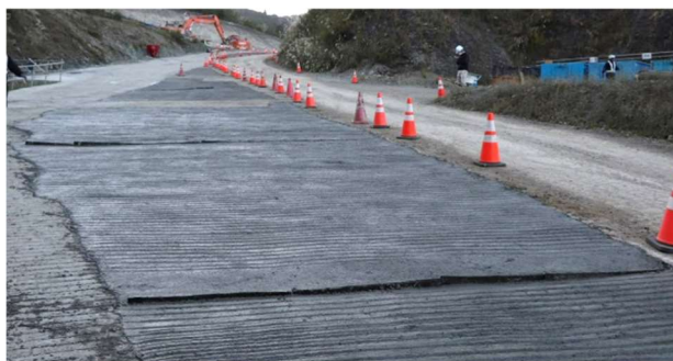
写真3 仕上がり状況
