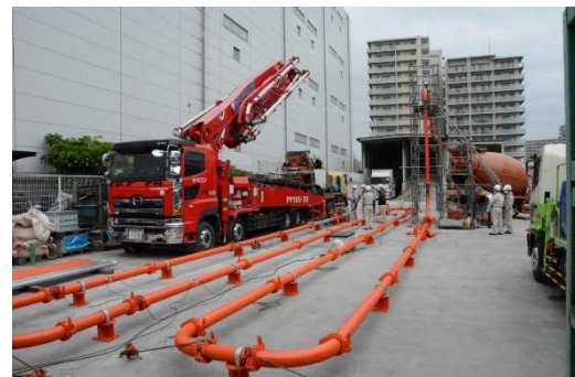
写真 1 圧送試験配管組立状況
